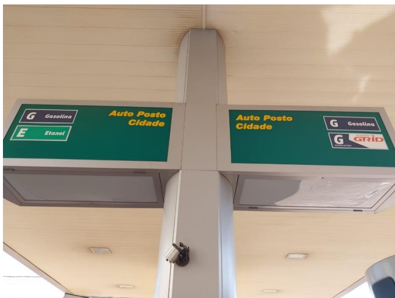
FOTO 53: Indicadores de produtos sobre as bombas.
