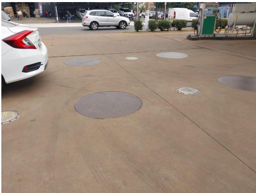
FOTO 14: Dois tanques de 30.000L bipartido jaquetado.
