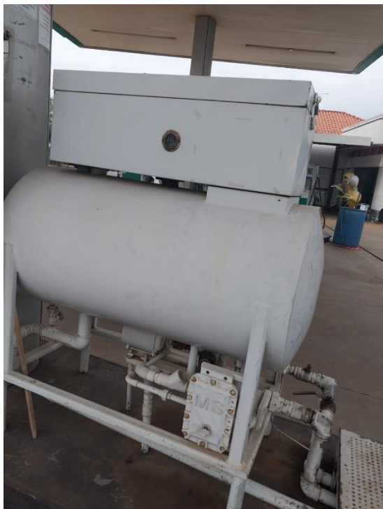
FOTO 18: Tanque de mil litros jaquetado de óleo queimado.
