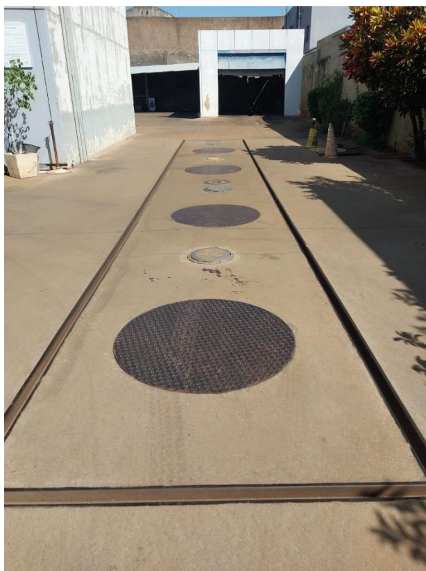
FOTO 52: Tanque de combustível 30.000L Bipartido 15x15.
