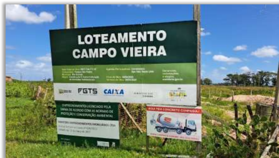
Foto 15: Placas instaladas na obra.
