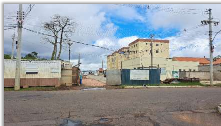
Foto 02: Acesso a obra pela Rua Treze de Maio.
