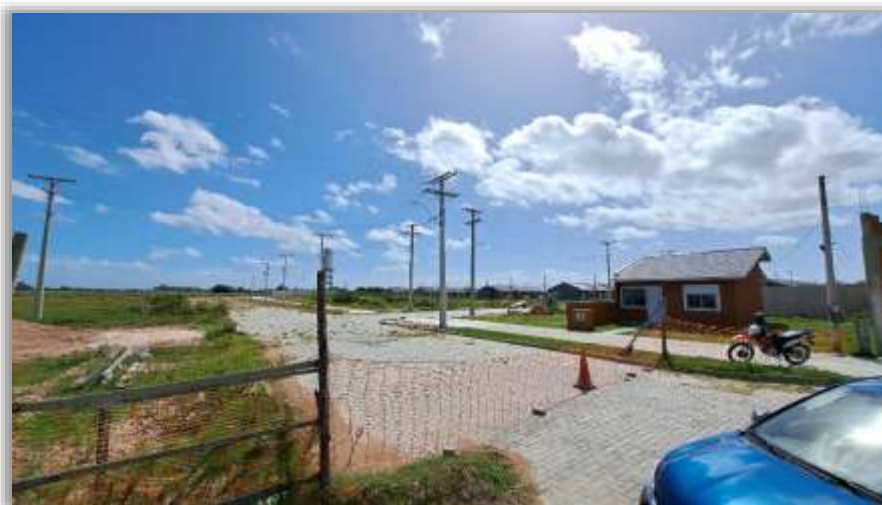
Foto 02: Acesso ao Loteamento pela Avenida Osvaldo Martense, a direita casa modelo.
