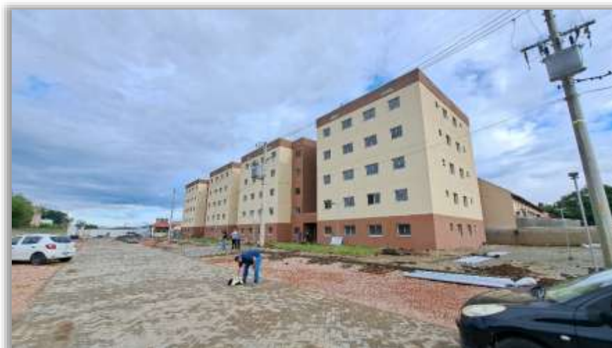
Foto 03: Vista da entrada da obra.
