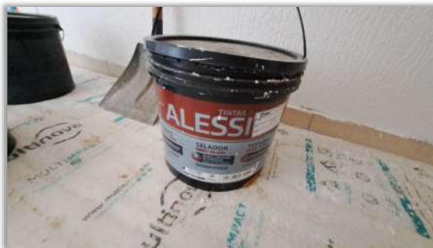
Foto 05: Material de pintura – selador.
