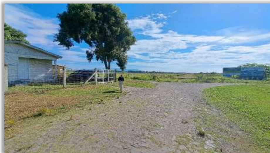
Foto 03: A esquerda escritório da obra, a direita acesso a obra pela Rua das Sempre Vivas.
