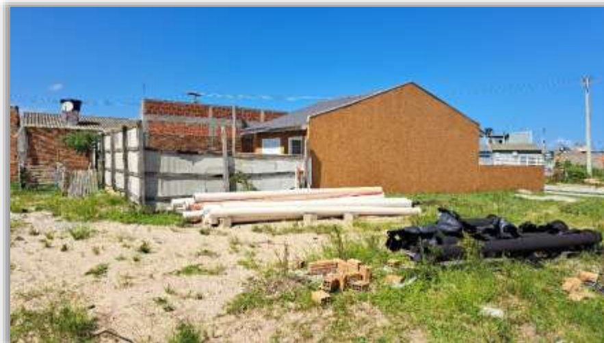
Foto 09: Tubulações no canteiro de obras.
