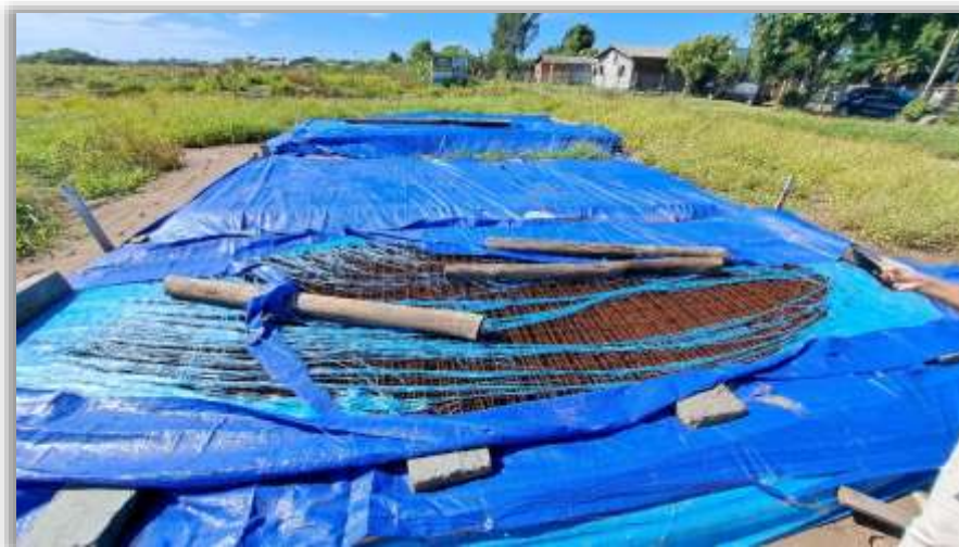
Foto 09: Malha pop armazenada na quadra 129.
