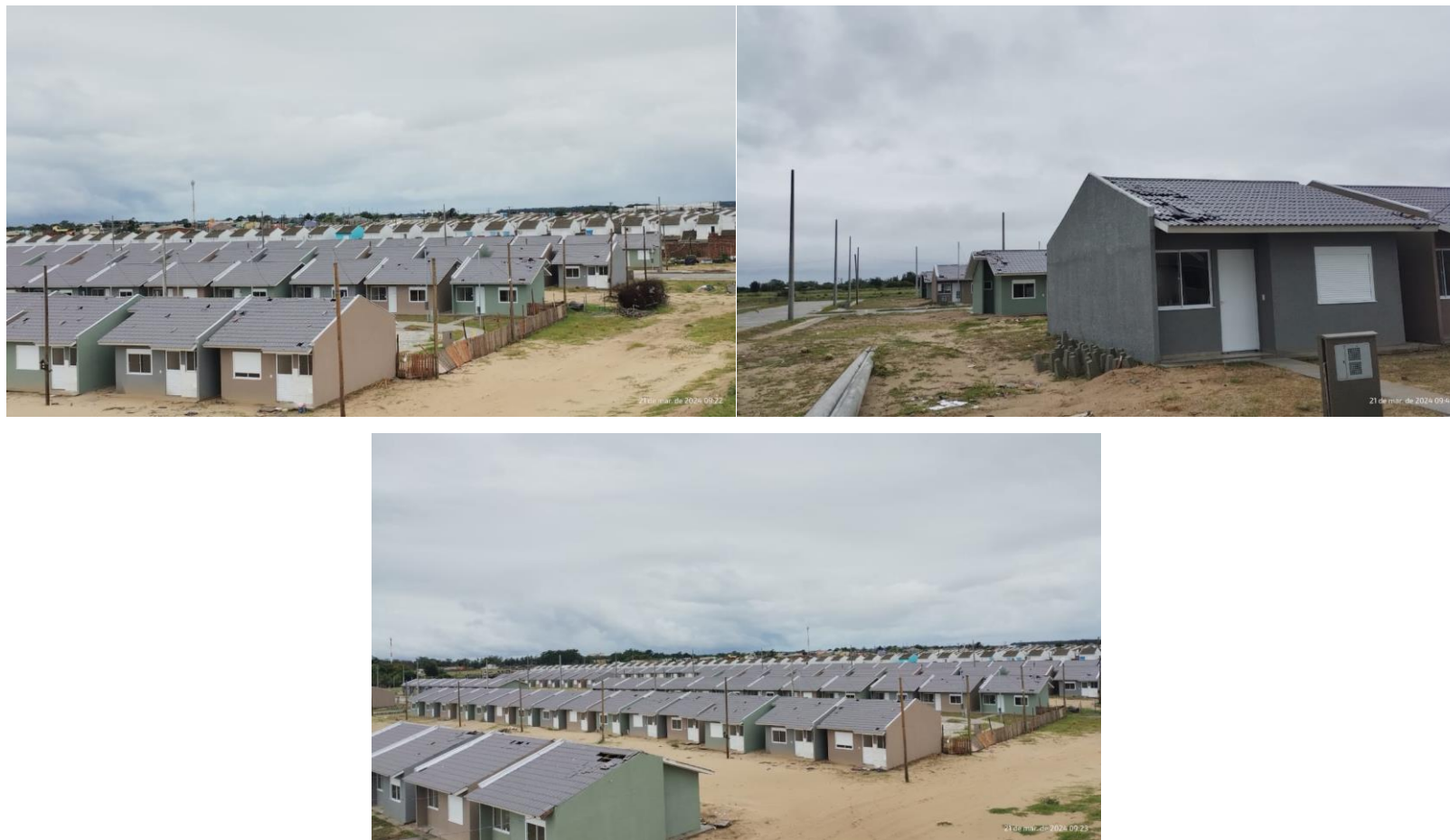
Figura 4 – Fotos sinistros ocorridos em 21/03/2024 no empreendimento SPE Vale Verde
