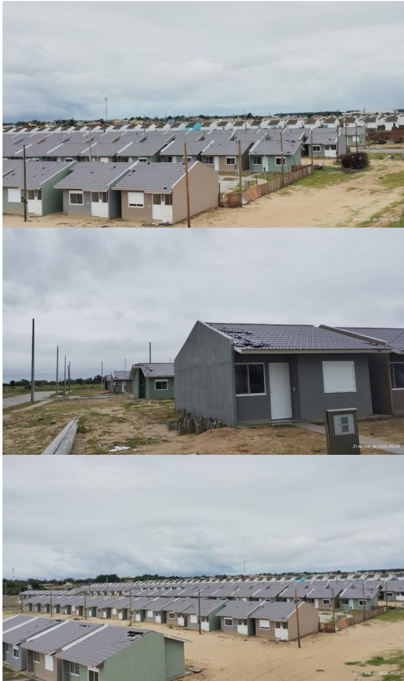
Figura 4 – Fotos sinistros ocorridos em 21/03/2024 no empreendimento SPE Vale Verde
